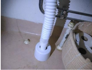
Bild på rör genomföringar i golvet på badrummet uppe.
