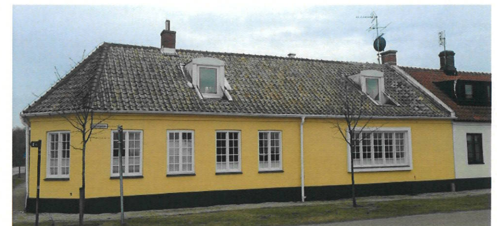
FASAD MOT VÄSTERGATAN, BEFINTLIGA TAKKUPOR
