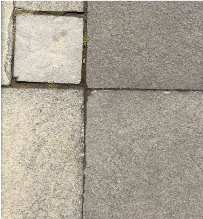
Fig 5: Uteplatser mot lägenheters entréside: Hand cut limestone, black eller dark grey. Mixade dimensioner 60x40x3 cm, 40x40x3 cm, 40x20x3 cm och 19x19x3 cm
