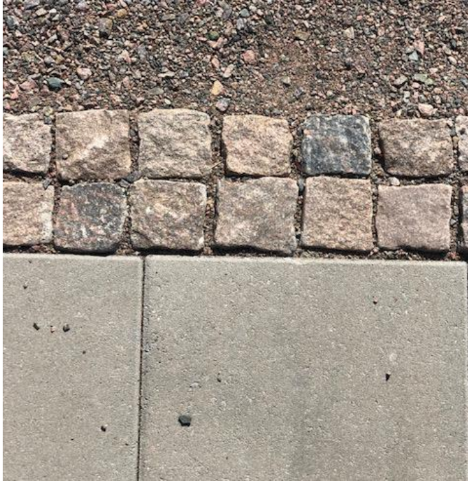
Fig 3: Parkering, grå betongplatta, Benders 40x40 cm ansluter mot gatsten och grus
