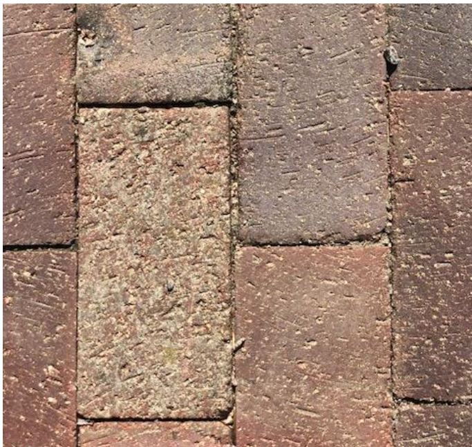
Fig 6: Uteplatser mot innergård och gemensamma gångstråk. Marktegel från Höganäs
