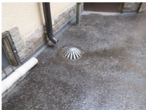
Gårdsbjälklag med brunn
