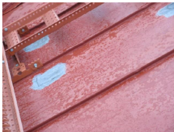
Provisoriska lagningar vid tidigare genomförningar
