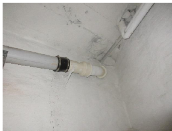
Gamla och nya avloppsrör
