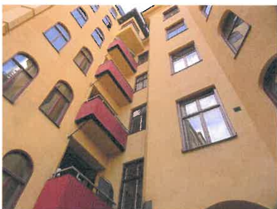
Gårdsfasad med balkonger i gott skick
