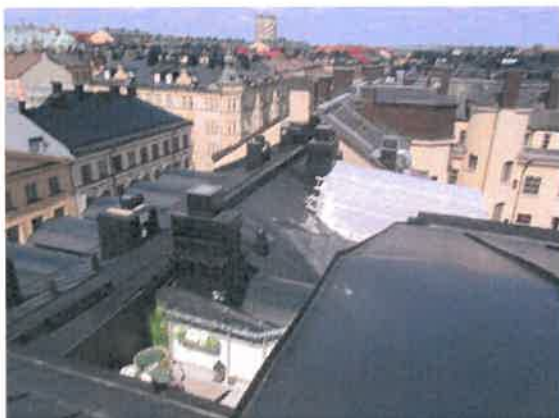
Tak med terrasser, en med pågående renovering
